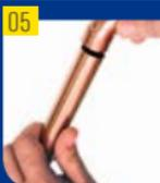
Inserir a extremidade do tubo na bolsa da conexão e deixá-la efetivamente encostada junto à base da bolsa. O conjunto formado deve ser fixado em lugar estruturalmente estável, de forma adequada para o prosseguimento da montagem.
