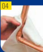
Aplicar o fluxo com a ajuda de um pincel na extremidade do tubo e da bolsa. O fluxo é utilizado para dissolver e remover traços de óxidos das superfícies, protegendo contra possível oxidação durante o aquecimento e favorecendo o processo de solda. Atenção: o fluxo não deve ser aplicado com os dedos, pois os produtos químicos são potencialmente agressivos quando entram em contato com os olhos ou feridas abertas.
