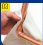
Limpar a extremidade do tubo e a bolsa da conexão, eliminando os óxidos, a oleosidade e as sujeiras da superfície decorrentes do corte, da rebarba e da escareação.
