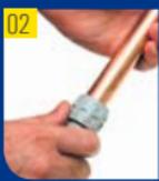
Rebarbar e escarear a extremidade do tubo para remover todas as irregularidades internas e externas decorrentes do corte.
