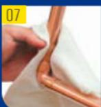
Aguardar o resfriamento natural da junta e, posteriormente, remover o excesso de fluxo com um pano úmido.
